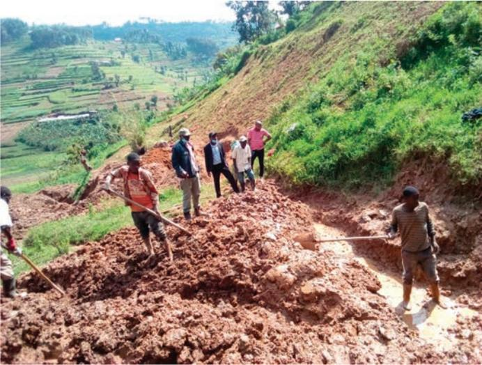
*Cette photo montre à la fois la beauté des paysages du Rwanda et le dur labeur de la construction d'un réseau d'eau gravitaire, qui a besoin d'une pente régulière, à travers, ou malgré, les collines. Ici, pas d'engins mécaniques, mais la force des bras !*
