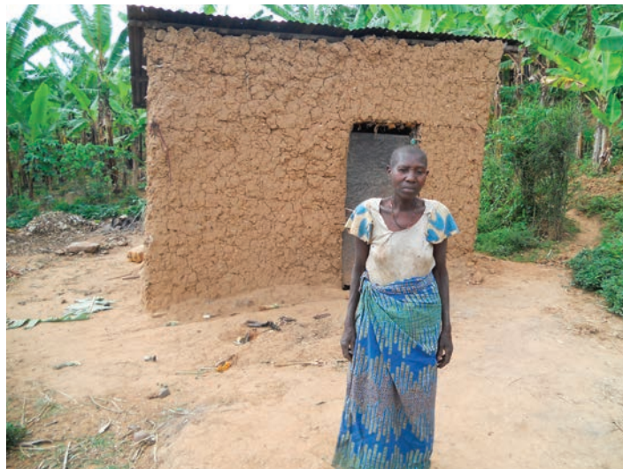
Mme Immaculée, veuve depuis 2016, vit avec ses trois enfants ; sa maison, minuscule, est construite en boue séchée. Très fragile, elle est entièrement à reconstruire en briques adobe.
